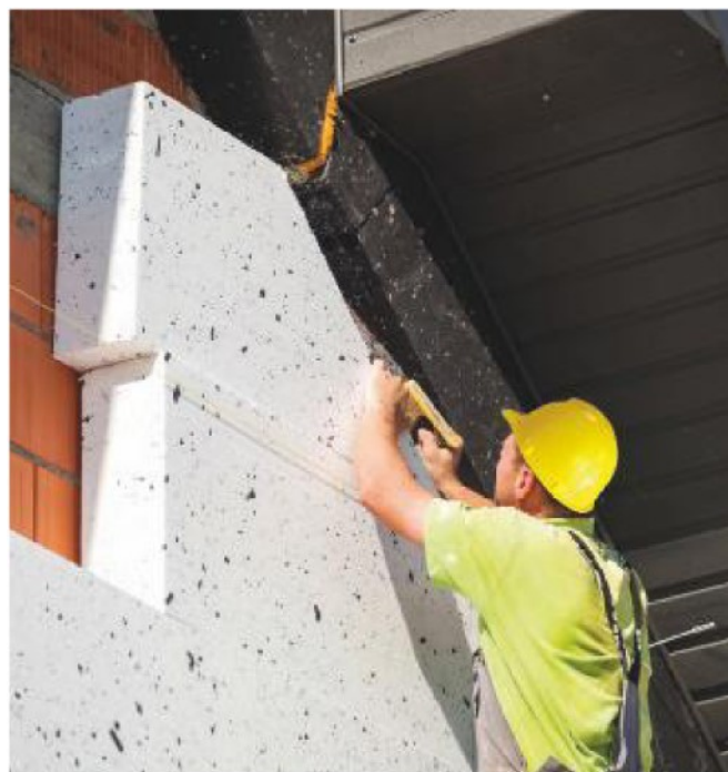
Il cappotto termico aiuta a efficientare gli edifici
