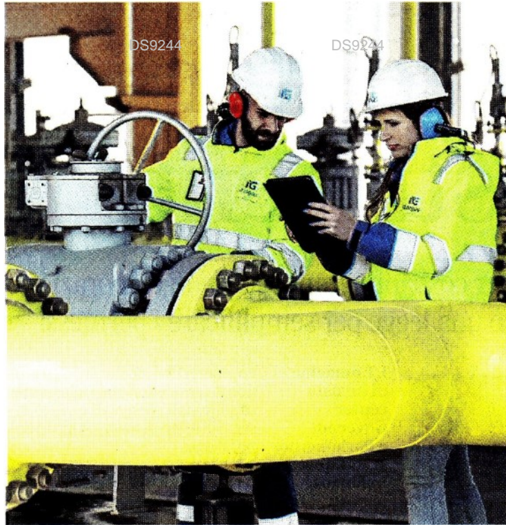
Tecnici al lavoro su un impianto di gas
